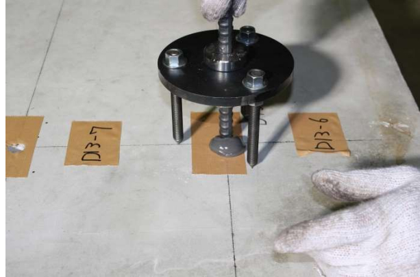
解図 2.2.2 アンカー打設用治具の例
