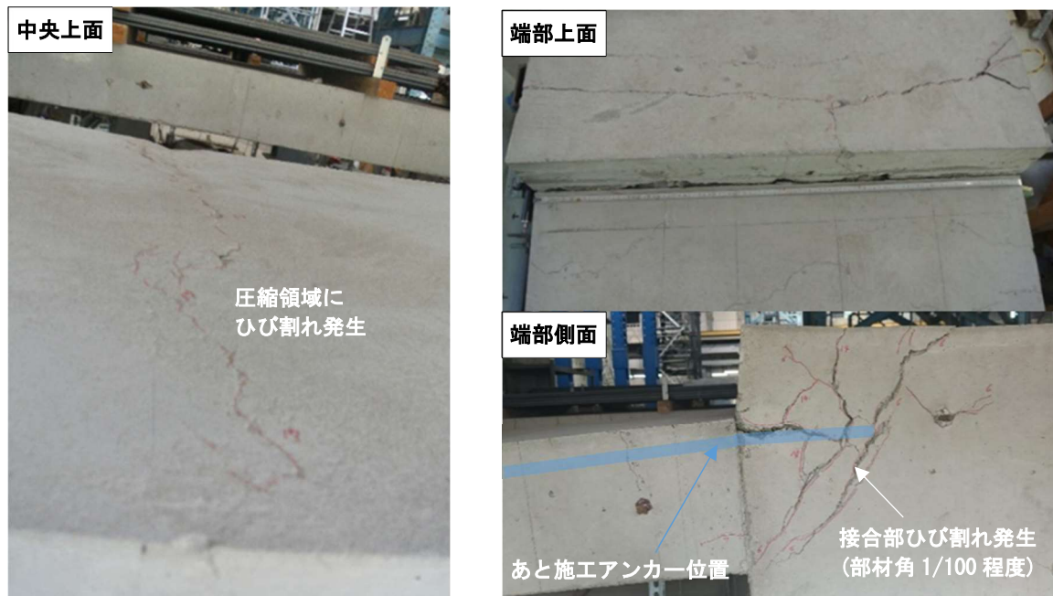
付図 5.4 最終破壊状況
