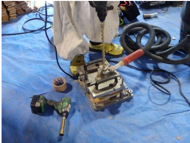
解図 2.1.6 穿孔用治具の例
