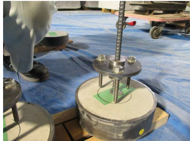
解図 2.1.7 アンカー施工用治具の例
