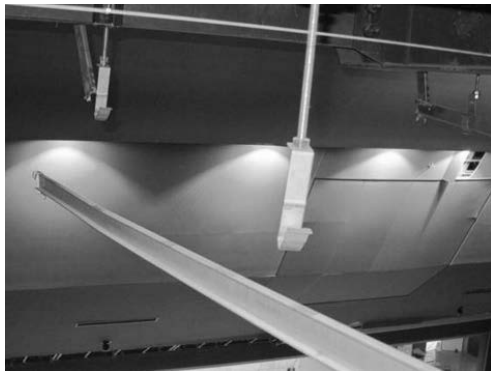
写真 2.3 ハンガーの開きによる外れ
