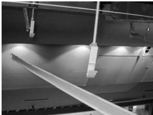
写真 2.3 ハンガーの開きによる外れ
