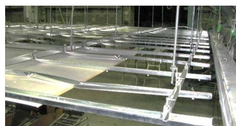
(b) 耐風圧クリップを用いた場合の 端部の天井板（ボード）の落下
